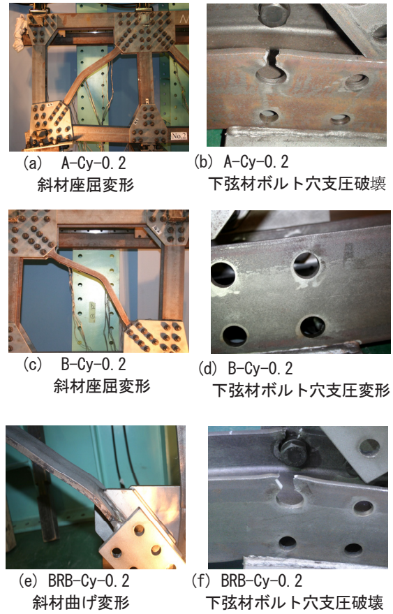
Fig. 11 供試体の損傷状態
