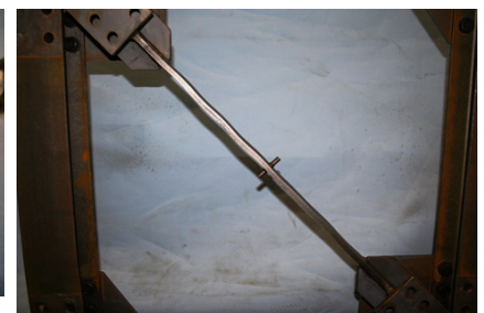
(b) 実験終了後のブレース材の変形状態(拘束材除去後) Photo. 5 BRB-Cy の損傷状態
