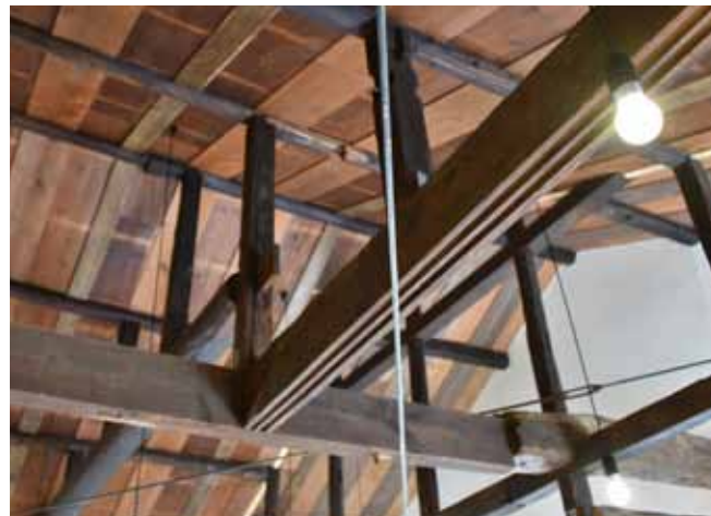
改修前の床材や天井板を用いたモザイク天井
