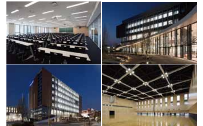
点灯したLED照明
