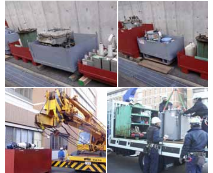
低濃度廃棄物 PCB の処分業者への引き渡し作業
