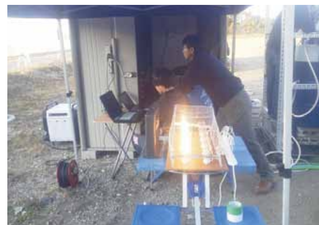
図4 改良型ガスエンジン発電機を用いた発電実験の様子
