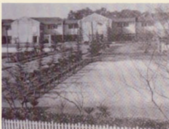
昭和29年12月～昭和30年末まで、「仮住まい」として使用された駒方校舎。
