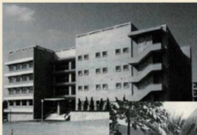
昭和41年に竣工した八事6号館
