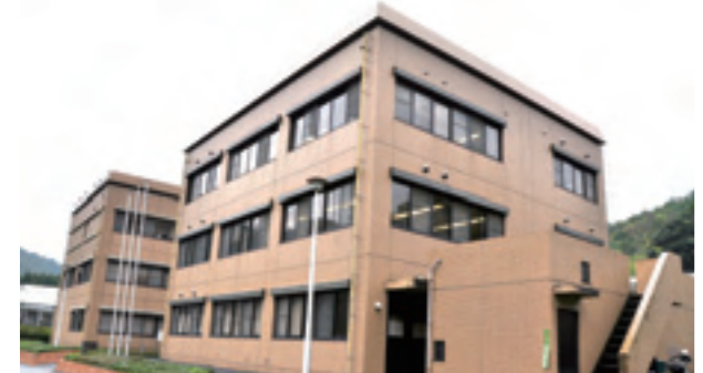
戸田さんが勤める財団法人が入る「広島市農業振興センター」の事務所棟と研究棟
