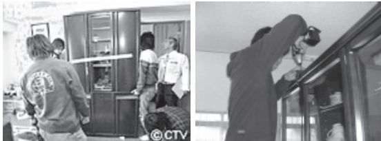
写真-3 施工作業の様子
