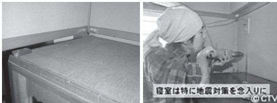
写真-4 金具取り付け後
