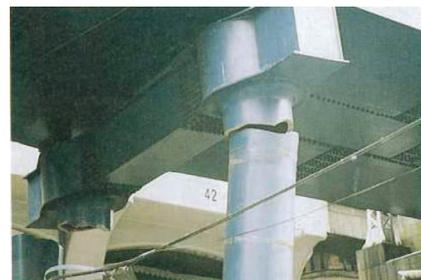
Photo 1 神戸高速鉄道の三宮駅付近の高架橋鑄鉄製橋脚の被害様子<sup>2)</sup>
