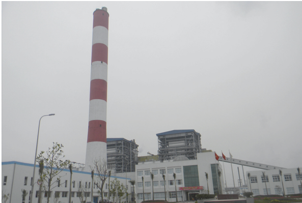
写真1 Pha Lai 石炭火力発電所の外観
