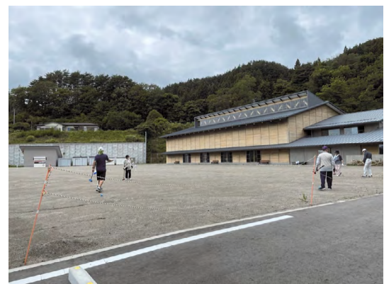
図 4：大槌町中央公民館安渡分館・避難ホール
