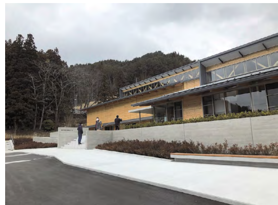
図 3：大槌町中央公民館赤浜分館・避難ホール
