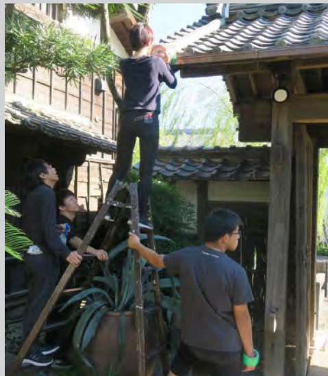
実測調査の様子
