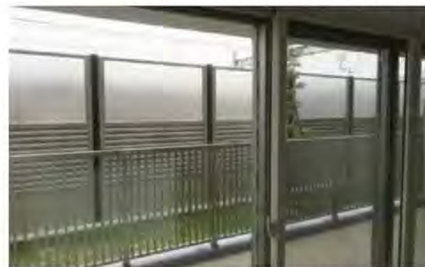
隣に鉄道が走る集合住宅。外への防音性能は高い。
